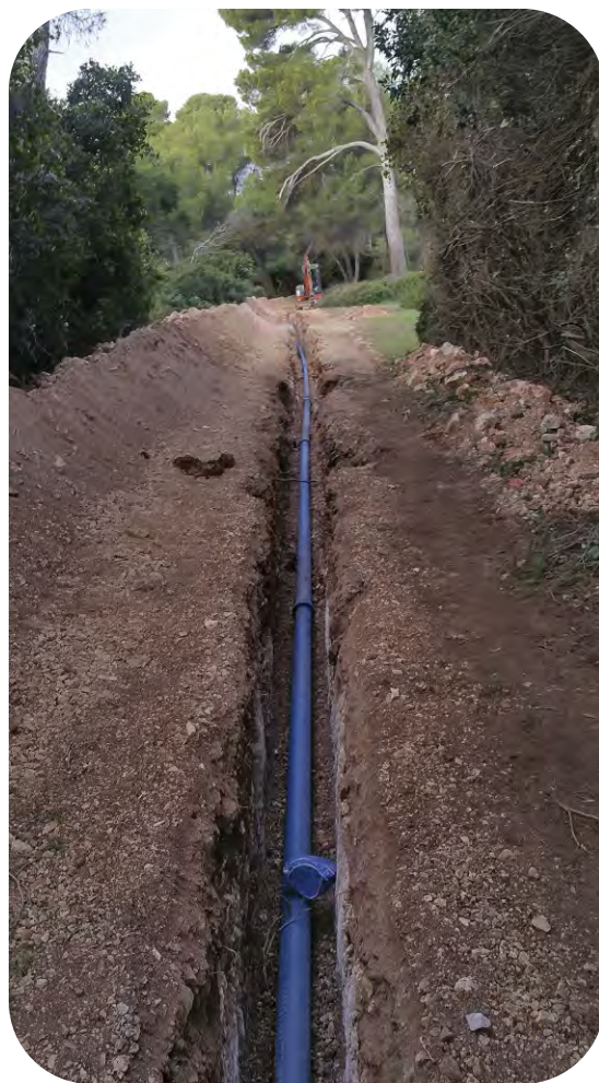
Pose de 5000 ml de réseau dédié à la DECI Ile Ste Marguerite Cannes
