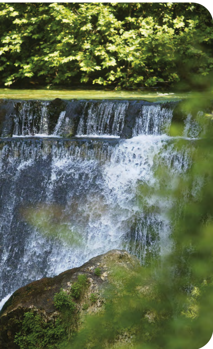
Barrage de St Cézaire sur Siagne
