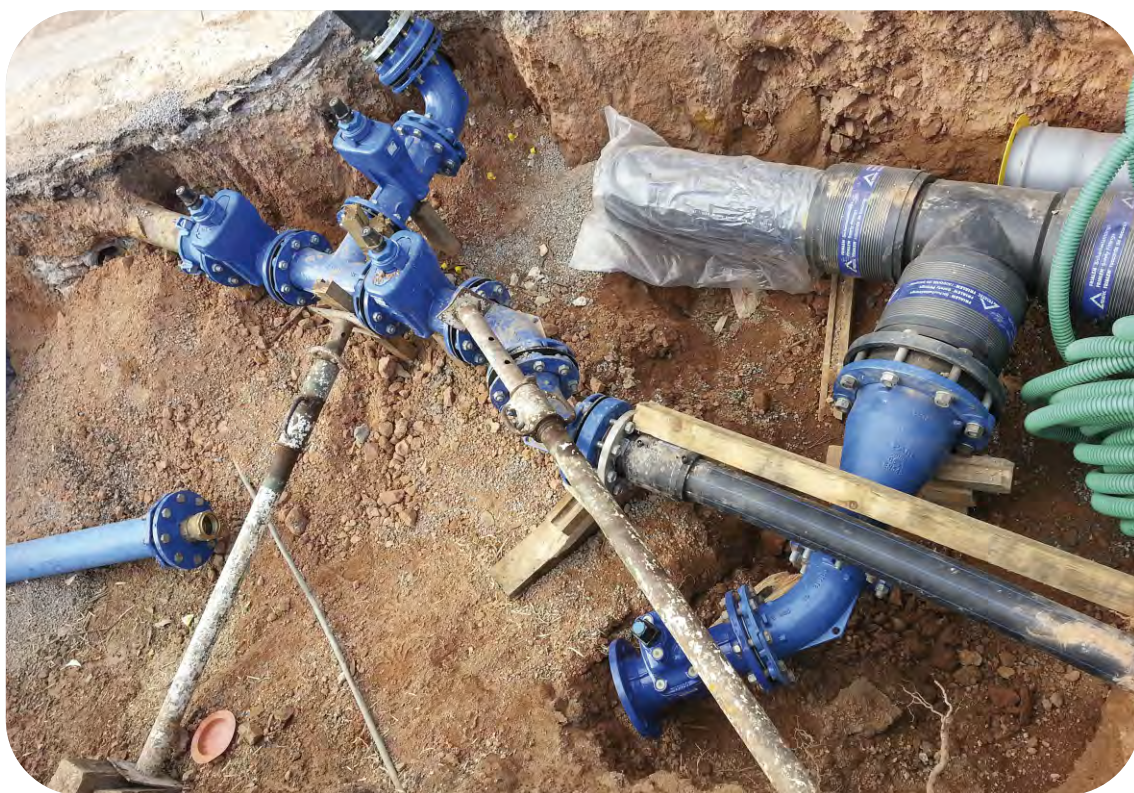
Renouvellement de la conduite de refoulement de la station de pompage Espéro Pax à Théoule
