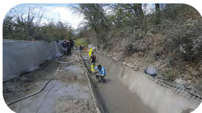
Travaux canal de la Siagne Masseboeuf Grasse Novembre 2016
