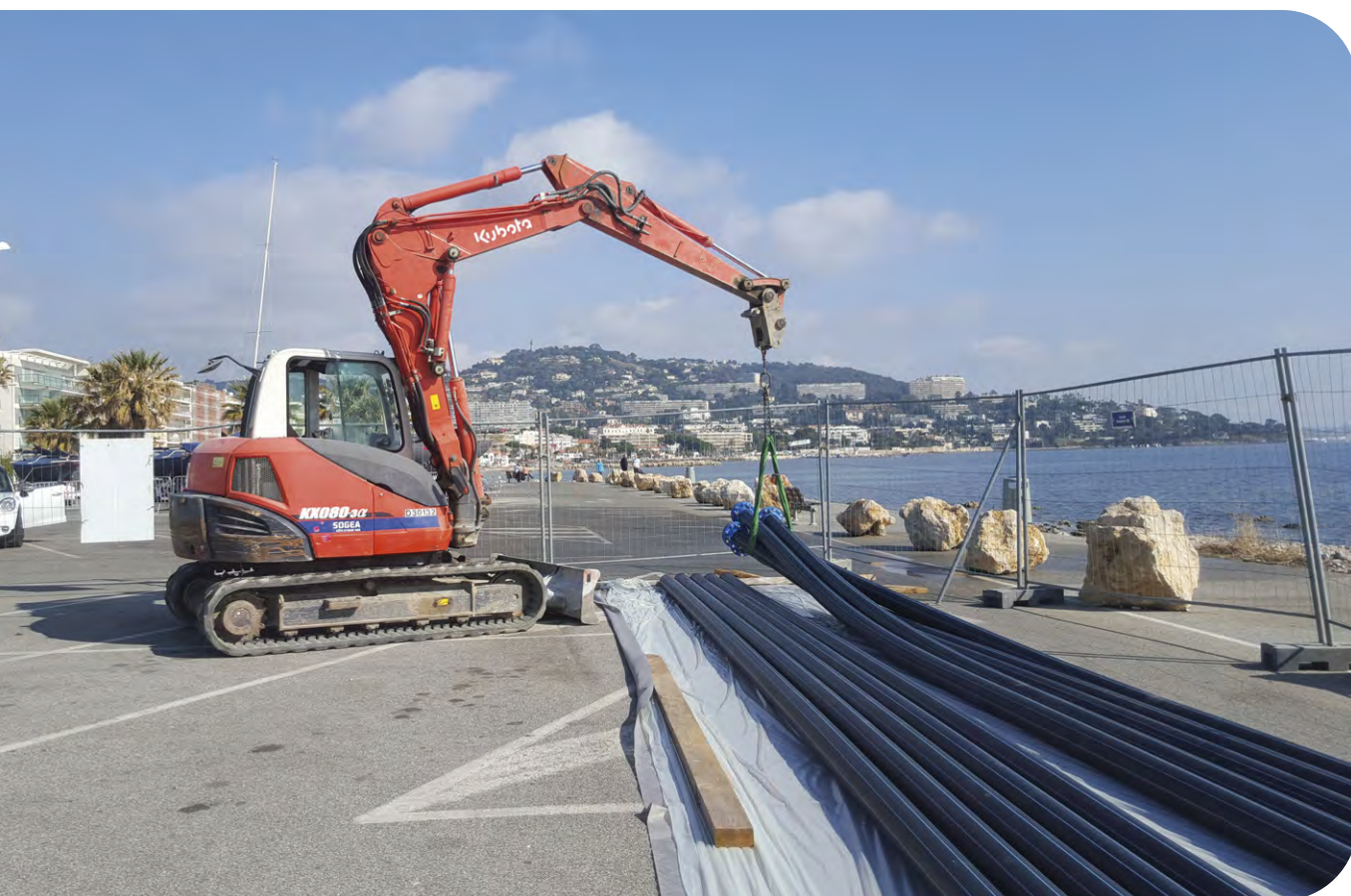
Pose de la conduite immergée entre la Pointe Croisette et l'île Sainte Marguerite à Cannes
