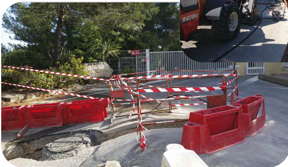
Extension pour maillage des réseaux d'eau potable à Mougins, voie Julia, avril 2016 : 90 ml de fonte DN 200 mm
