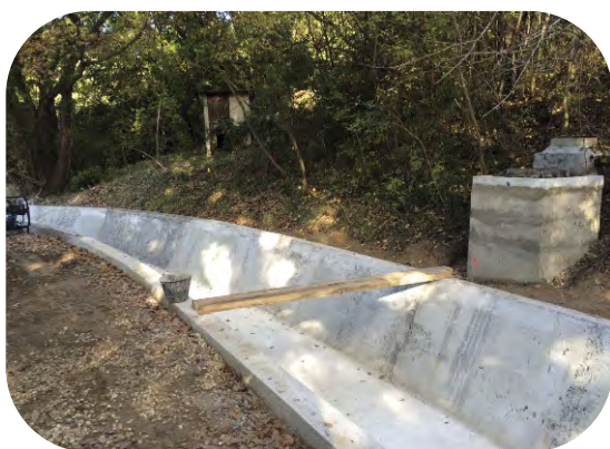
Travaux canal de la Siagne à Mouans Sartoux
