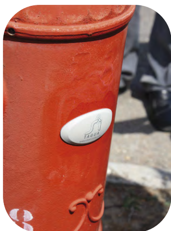
Pose de puces sur les poteaux incendies
