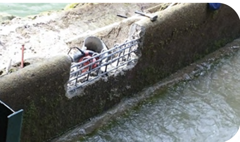
Echancrure réalisée au niveau de la lame de surverse du barrage de St Cézaire
