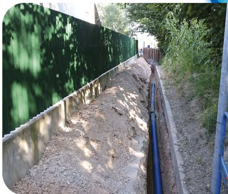
Extension du réseau d'eau potable au skate park de La Roquette sur Siagne : 174 ml canalisation fonte DN100 et pose d'une bouche d'incendie
