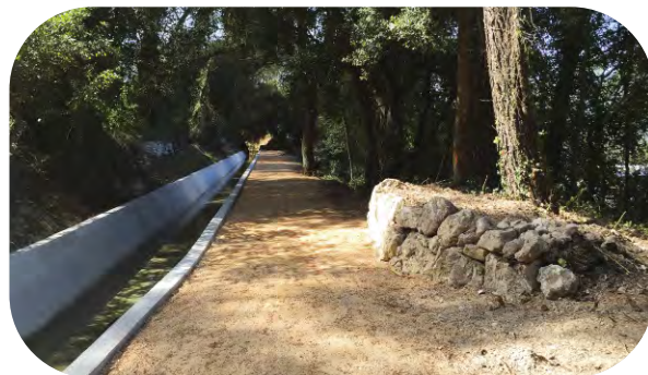
Travaux canal de la Siagne Vallon d'Aussel Mouans Sartoux - Mars 2016
