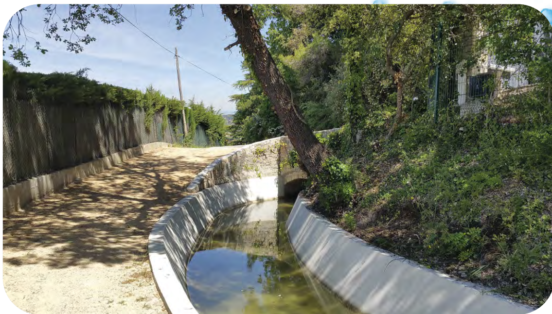
Renouvellement patrimonial du canal de la Siagne à Mougins
