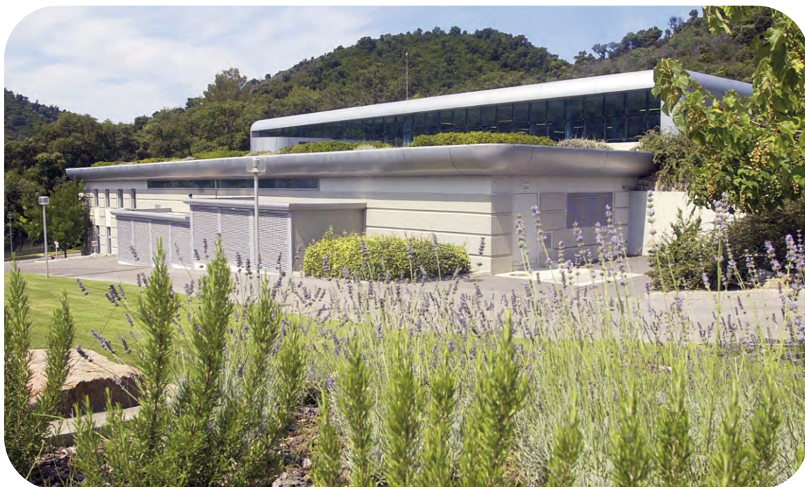
Apié - Usine d'ultrafiltration
