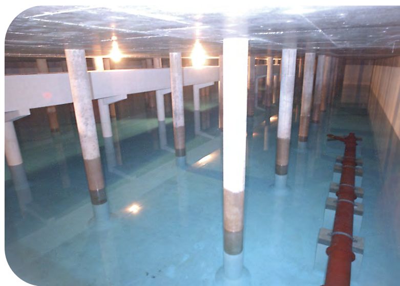
Réservoir du Périer
