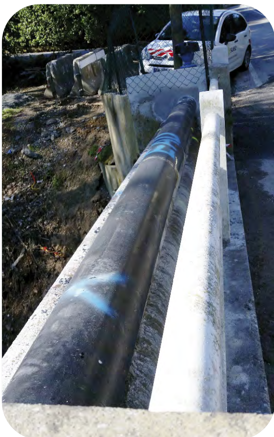
Dévoisement du réseau d'eau potable à Mougins, suite aux inondations du 3 octobre 2015 Avenue des mimosas : 24 ml conduite fonte DN100/ 4 ml canalisation Isopam 100 mm
