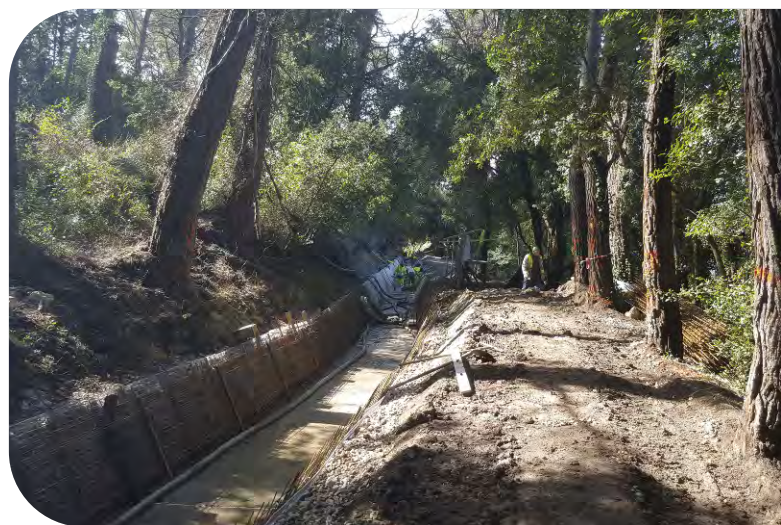
Travaux canal de la Siagne à Mouans Sartoux
