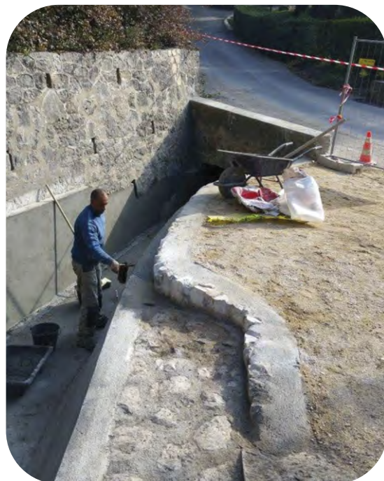
Travaux Chute Eau Masseboeuf Canal de la Siagne - Novembre 2016
