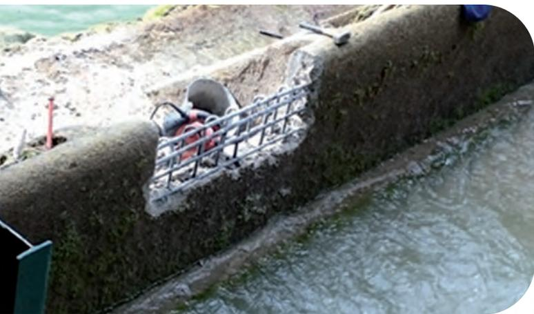
*Echancrure réalisée au niveau de la lame de surverse du barrage de St Cézaire*
