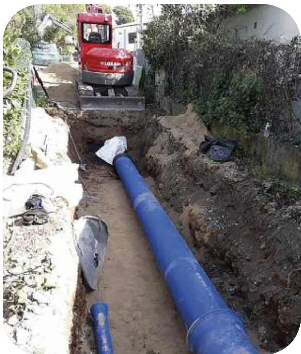
Renouvellement 360 mètres de feeder AEP 400 mm + 360 mètres de distribution 100 mm Allée provençale au Cannet
