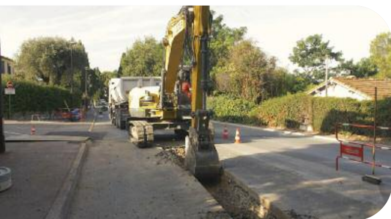
Renouvellement de 1200 mètres de réseau AEP en fonte - Avenue Maurice Chevalier à Cannes (phase 2 entre pont de l'A8 et l'école Pagnol)
