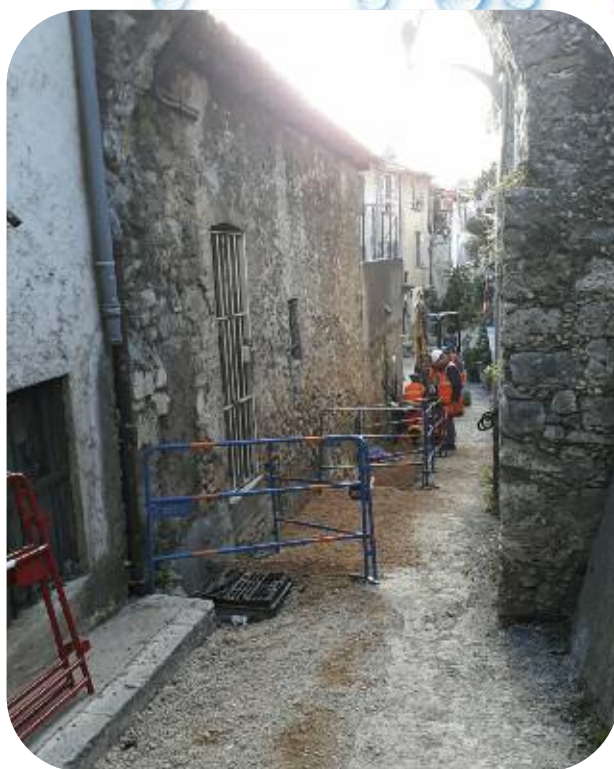
Renouvellement de 105 mètres de réseau AEP en PEHD diamètre 75 et 63 mm - Rue de la Ressence à Vallauris
