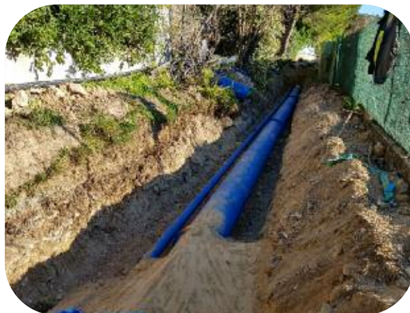
Renouvellement - 380 mètres de feeder AEP 400mm + 300 mètres de distribution 100mm Chemin des Campelières à Mougins
