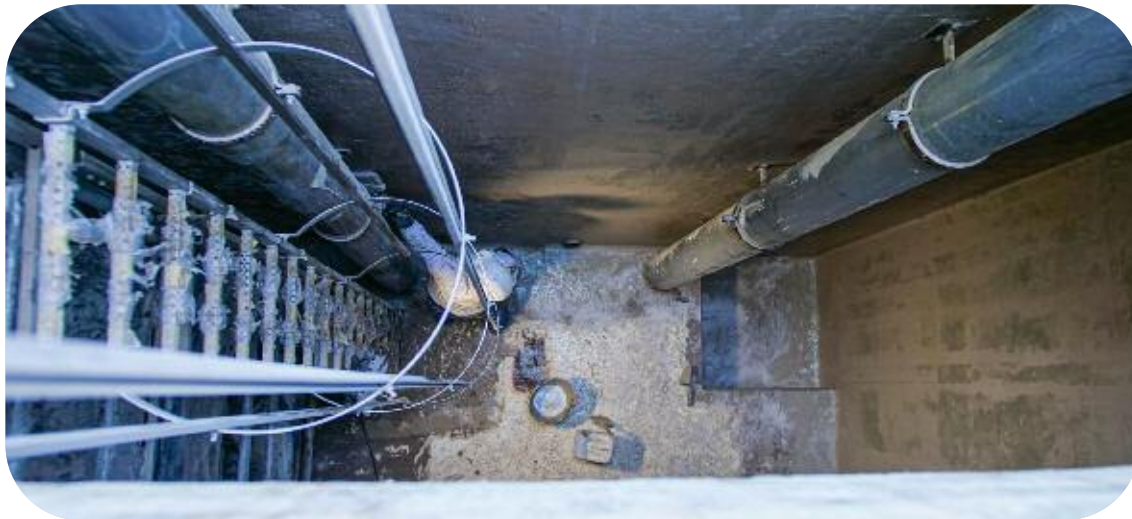
Rénovation du réservoir Cote 60 à Théoule-sur-Mer
