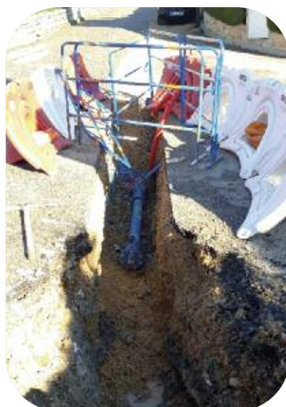
Renouvellement de 430 mètres de réseau AEP 150 mm - Bd Gazagnaire (phase 2) à Cannes
