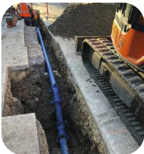
Renouvellement de 430 mètres de réseau AEP 150 mm - Bd Gazagnaire (phase 2) à Cannes
