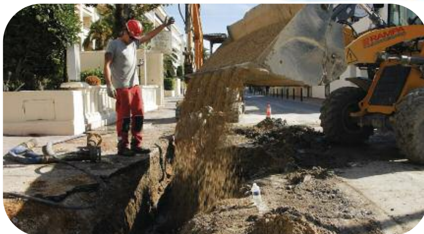
Renouvellement du réseau AEP en fonte diamètre 200 mm sur 480 mètres Avenue de Lérins à Cannes
