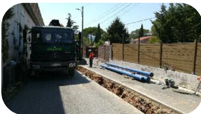
Travaux de renouvellement et redimensionnement 750 mètres en 150 mm et pose de trois hydrants Chemin de l'espagnol et chemin des Primevères à Mougins
