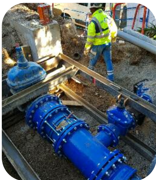
Renouvellement - 380 mètres de feeder AEP 400mm + 300 mètres de distribution 100mm Chemin des Campelières à Mougins
