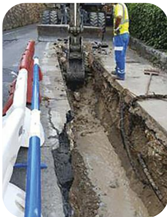
Travaux de création de 1000 mètres de FEEDER et de 900 mètres de distribution 100mm Route de Valbonne au Cannet
