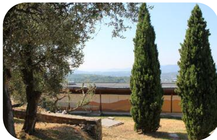
Usine de Châteauneuf
