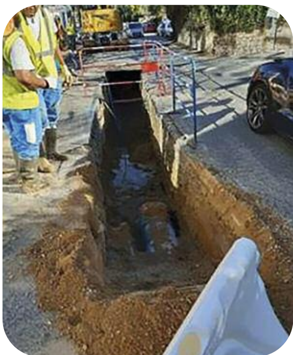
Travaux de création de 1000 mètres de FEEDER et de 900 mètres de distribution 100mm Route de Valbonne au Cannet
