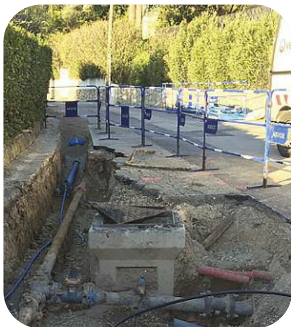
Renouvellement du réseau d'eau potable 278 mètres en diamètre 100 mm Avenue Chagall Mandelieu-La Napoule
