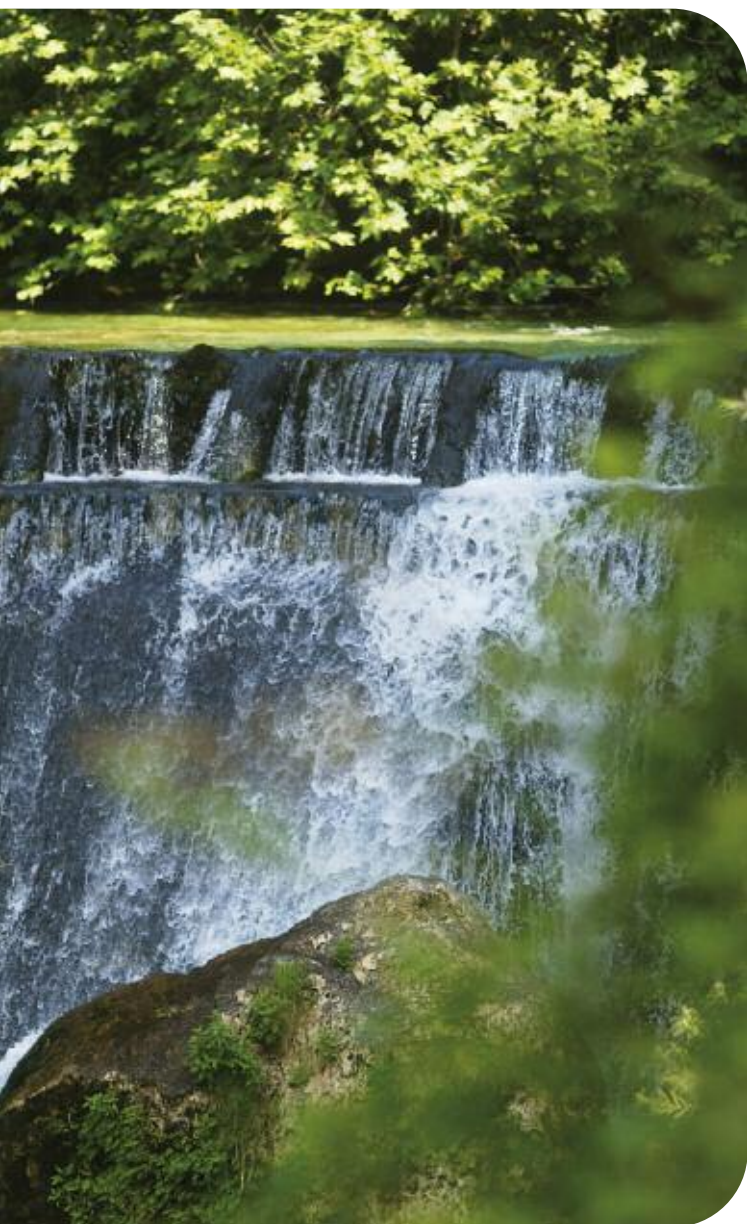
Barrage de St Cézaire sur Siagne
