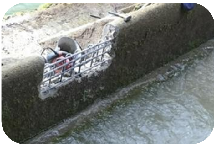
Echancrure réalisée au niveau de la lame de surverse du barrage de St Cézaire
