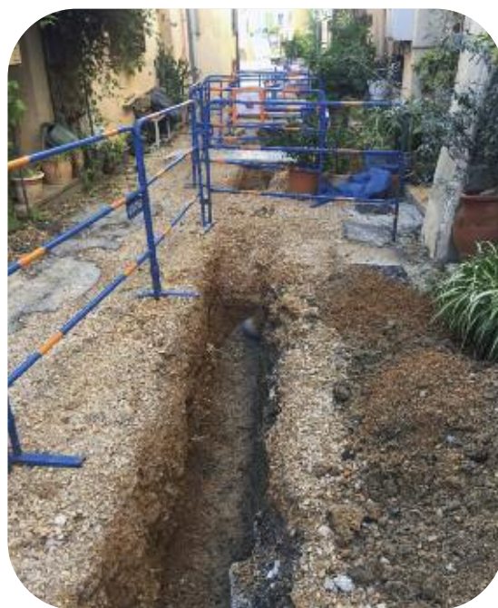
Renouvellement de 105 mètres de réseau AEP en PEHD diamètre 75 et 63 mm - Rue de la Ressence à Vallauris
