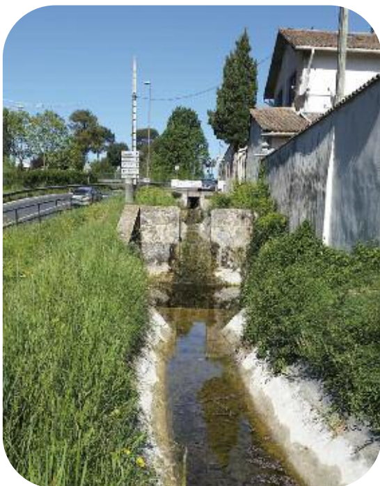
Canal de la Siagne, Mougins
