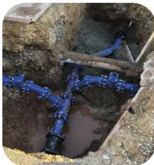
Renouvellement de 430 mètres de réseau AEP 150 mm - Bd Gazagnaire (phase 2) à Cannes
