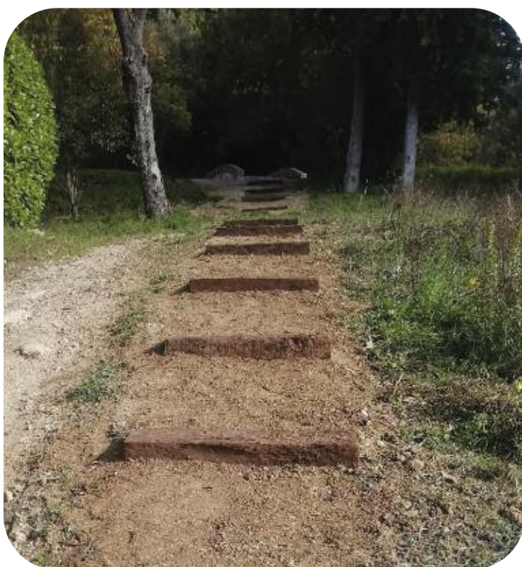
Amélioration de l'accès Promenade du Moulin de la Croix à Mougins
