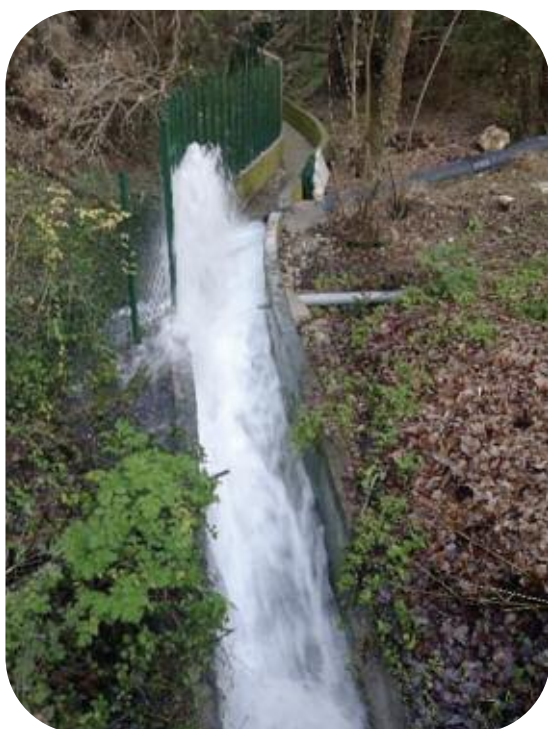
Purge réalisée à 2000 m³/h
