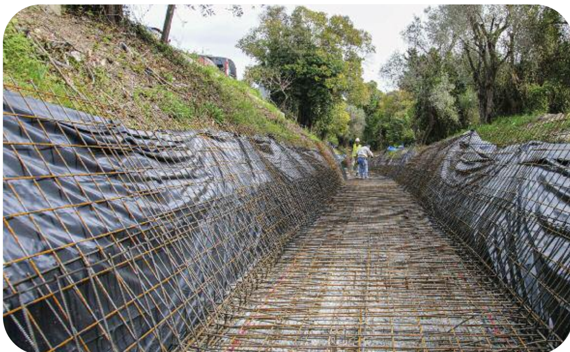
Renouvellement du Canal de la Siagne 150 mètres Chemin de Pigranel Mougins
