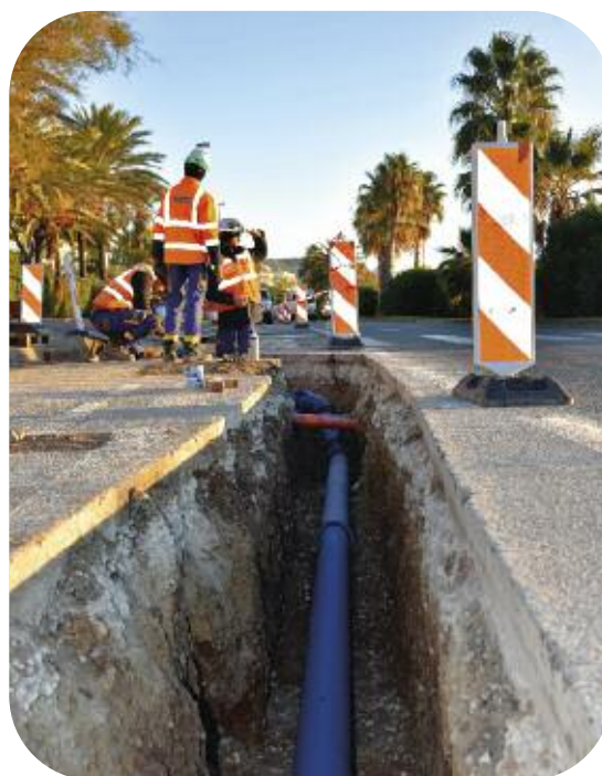
Extension du réseau d'eau potable - 110 mètres diamètre 150 mm - desserte du futur complexe hôtelier - Bd du Midi à Cannes La Bocca
