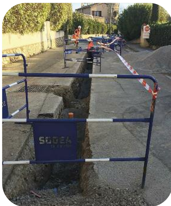
Renouvellement du réseau d'eau potable 278 mètres en diamètre 100 mm Avenue Chagall Mandelieu-La Napoule
