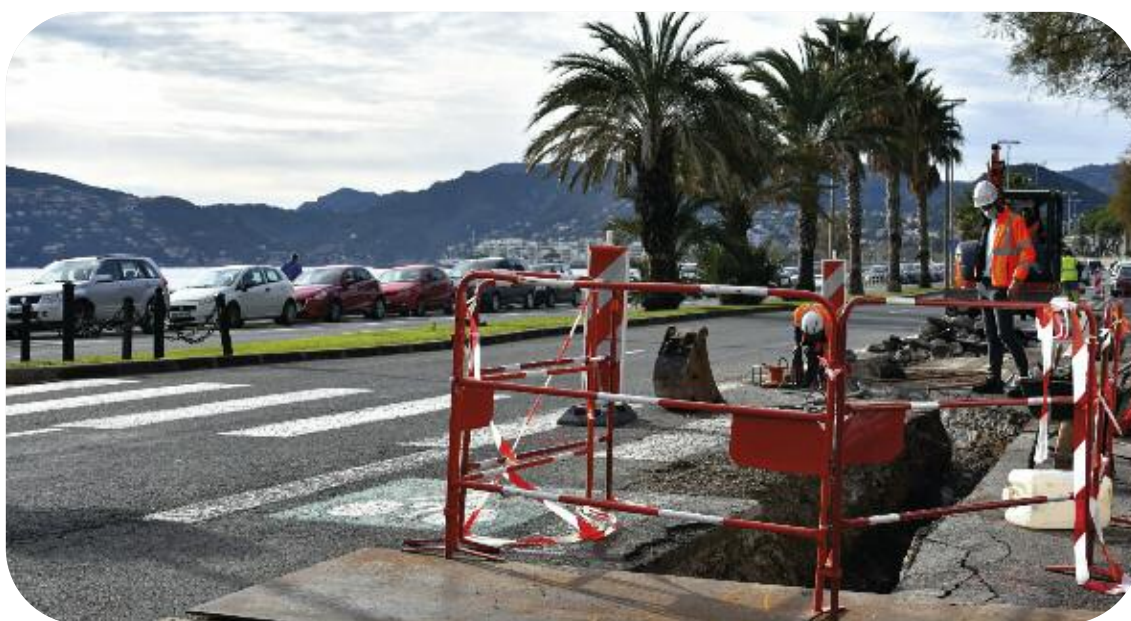
Extension du réseau d'eau potable - 110 mètres diamètre 150 mm Desserte du futur complexe hôtelier - Bd du Midi à Cannes La Bocca
