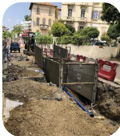
Renouvellement de 220 mètres de réseau AEP en fonte ductile DN 100 mm - Bd République à Cannes
