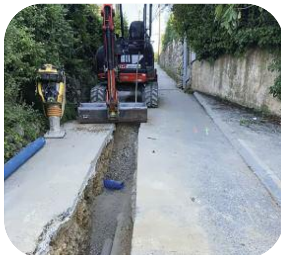
Renouvellement de 127 mètres de réseau AEP en fonte ductile DN 100 mm Chemin du Piccolaret - Mougins/Le Cannet (en limite des 2 communes)
