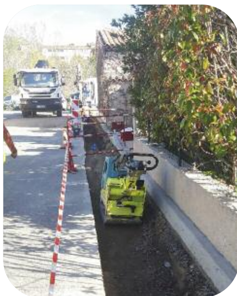
Renouvellement de 230 mètres de canalisation en fonte diamètre 60/100 mm Chemin des Sausserons à Pégomas
