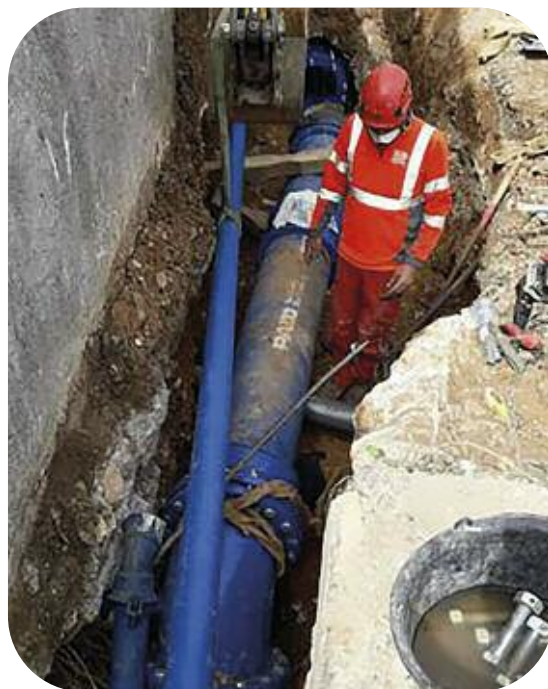
Renouvellement 360 mètres de feeder AEP 400 mm + 360 mètres de distribution 100 mm Allée provençale au Cannet
