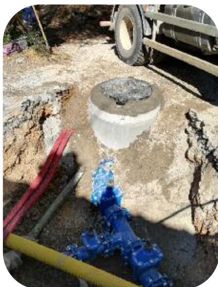
Renouvellement de 220 mètres de réseau AEP en fonte ductile DN 100 mm - Bd République à Cannes
