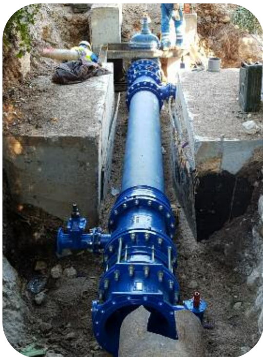
Renouvellement - 380 mètres de feeder AEP 400mm + 300 mètres de distribution 100mm Chemin des Campelières à Mougins
