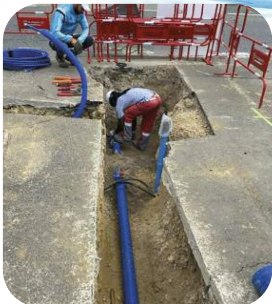
Renouvellement de 127 mètres de réseau AEP en fonte ductile DN 100 mm Chemin du Piccolaret - Mougins/Le Cannet (en limite des 2 communes)
