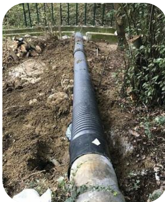
Canalisation de vidange posée en DN400
