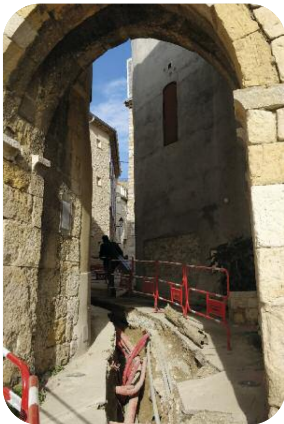
Renouvellement du réseau d'eau potable Mougins Village Place de l'église, Porte Sarrazine, rue de la Glissade : 80 mètres de fonte ductile en 100 mm et reprise des branchements
