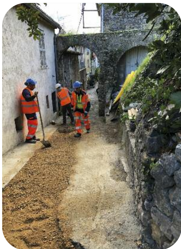
Renouvellement de 105 mètres de réseau AEP en PEHD diamètre 75 et 63 mm - Rue de la Ressence à Vallauris
