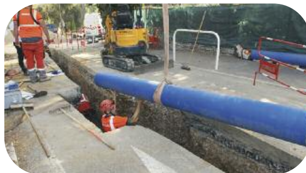
Renouvellement de 1200 mètres de réseau AEP en fonte - Avenue Maurice Chevalier à Cannes (phase 2 entre pont de l'A8 et l'école Pagnol)
