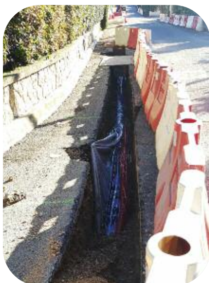
Raccordement des réseaux d'eau potable 600 mètres en 100 mm Domaine de Tournamy à Mougins
