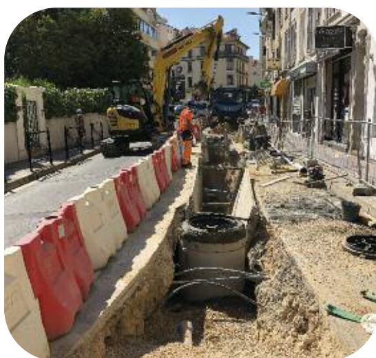
Renouvellement de 220 mètres de réseau AEP en fonte ductile DN 100 mm - Bd République à Cannes
