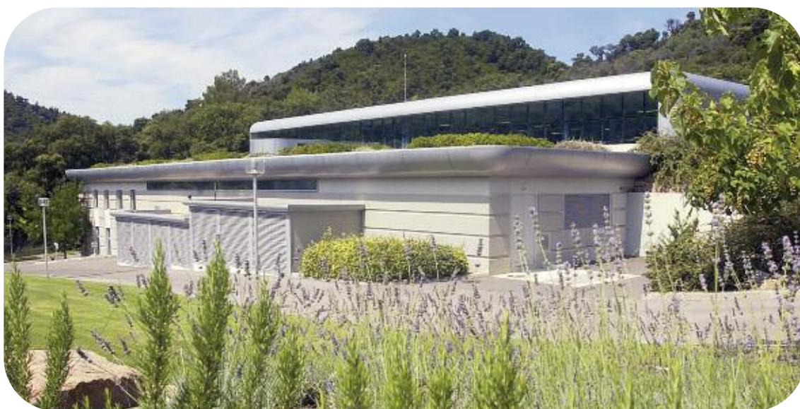
Apié - Usine d'ultrafiltration
