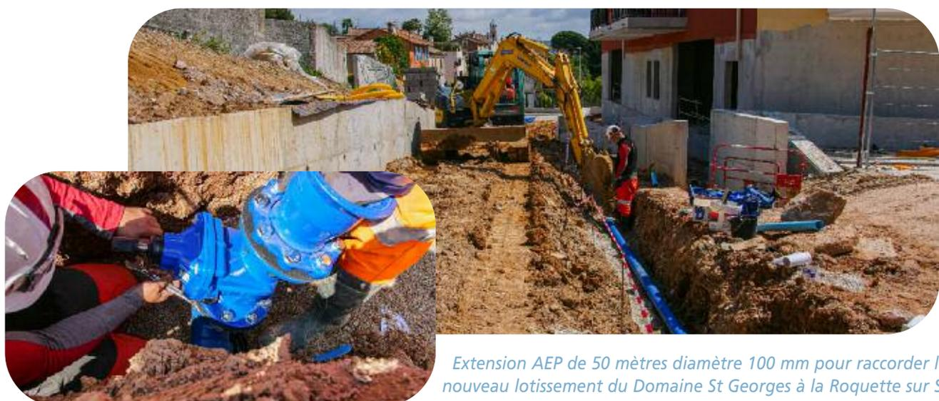
*Extension AEP de 50 mètres diamètre 100 mm pour raccorder le nouveau lotissement du Domaine St Georges à la Roquette sur Siagne*
