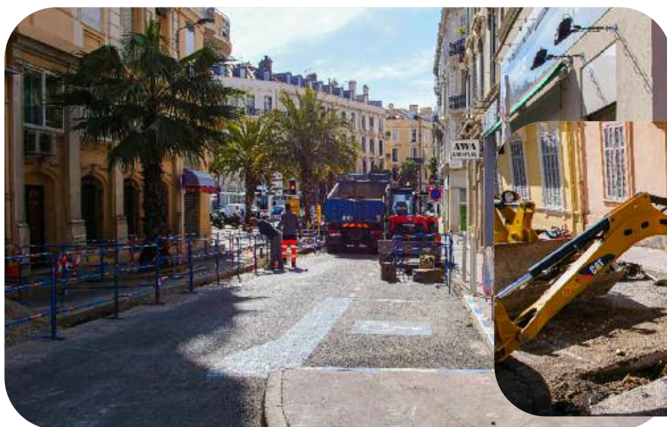
Renouvellement de 300 mètres de réseau AEP, rue Léopold Bucquet à Cannes la Bocca
