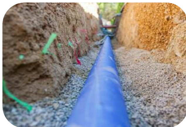
Renouvellement de réseau AEP 80 mm et 250 mètres Résidence Mas des Pins, 572 bd de la corniche à Mougins village
