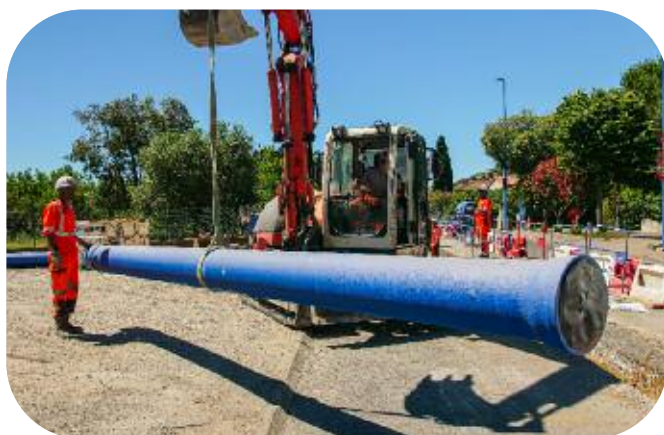
Renouvellement de 600 mètres de réseau AEP diamètre 300 mm, avenue du Général Garbay à Mandelieu, juin 2021
