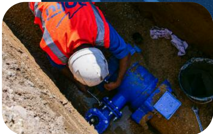
Renouvellement de 800 mètres de réseau AEP fonte DN 300 diamètre 300 mm, avenue Gaston de Fontmichel à Mandelieu, avril 2021
