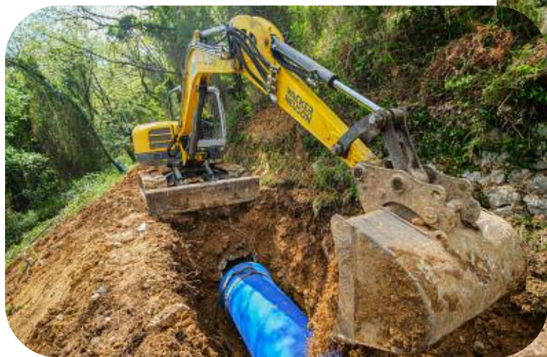
Renouvellement de 110 mètres du Canal du Loup diamètre 800mm phase 2, chemin du Château d'eau à Le Bar-sur-Loup
