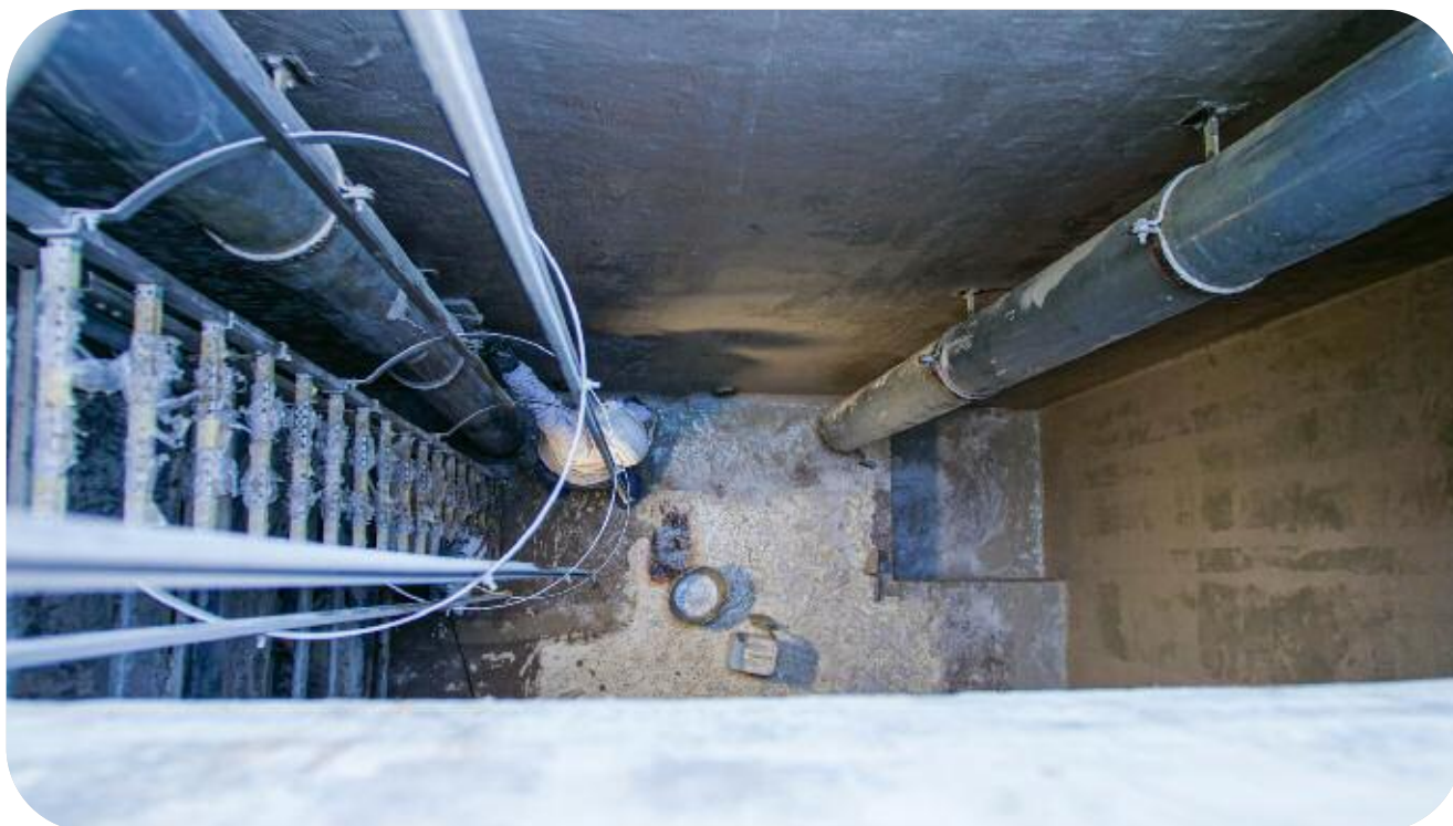
Réfection du réservoir AEP cote 60, bd de la Source à Théoule-Sur-Mer
