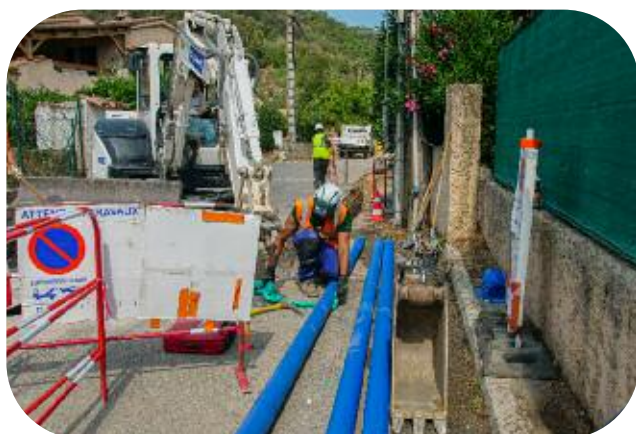
Renouvellement de 340 mètres de réseau AEP, Chemin des chênes à Pégomas, juin 2021
