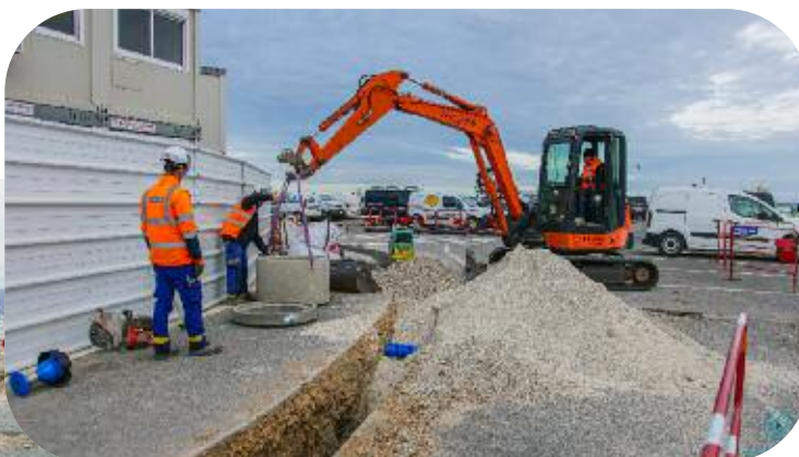
Renouvellement de réseau AEP 180 mètres, 160 mm de diamètre, parking Franklin Roosevelt au Palm Beach à Cannes
