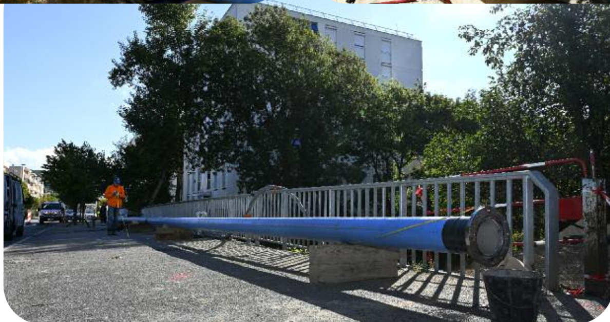
Renouvellement de 170 mètres de réseau AEP, avenue des buissons ardents, Nouvelle Frayère à Cannes la Bocca, octobre 2021
