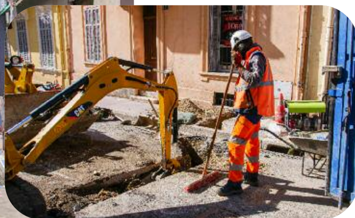
Renouvellement de 300 mètres de réseau AEP, rue Léopold Bucquet à Cannes la Bocca
