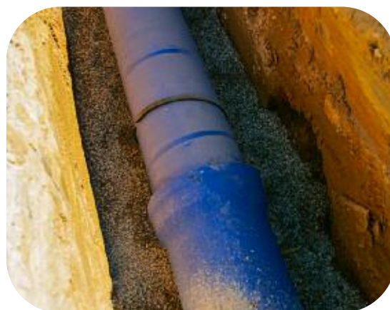
Renouvellement de 600 mètres de réseau AEP diamètre 300 mm, avenue du Général Garbay à Mandelieu, juin 2021
