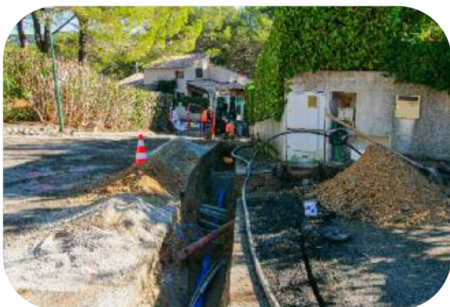
Renouvellement de réseau AEP 80 mm et 250 mètres Résidence Mas des Pins, 572 bd de la corniche à Mougins village
