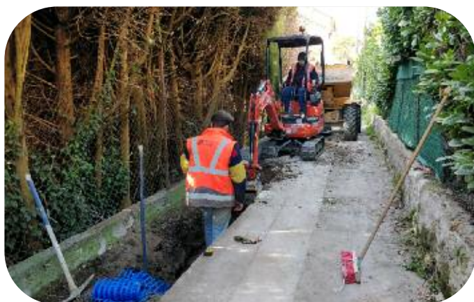
Renouvellement de 120 mètres de réseau AEP, 468 chemin Chemin de la Gabelle à Vallauris, février 2021
