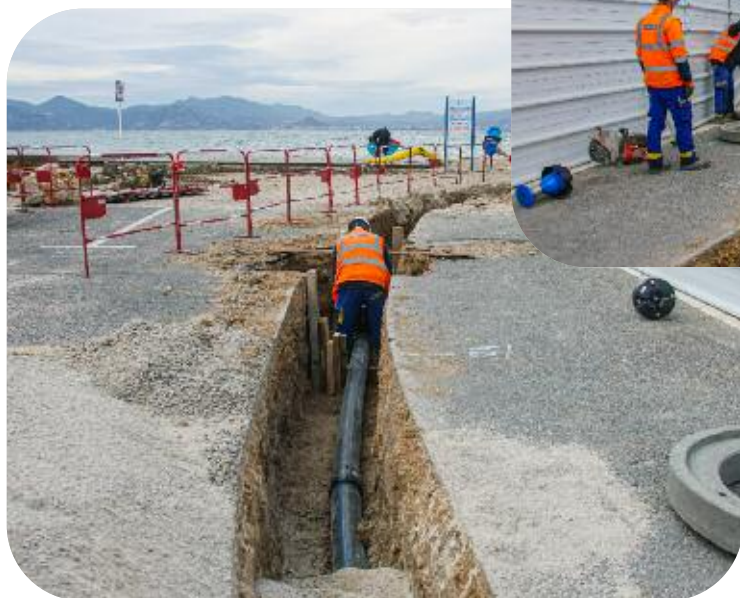
Renouvellement de réseau AEP 180 mètres, 160 mm de diamètre, parking Franklin Roosevelt au Palm Beach à Cannes
