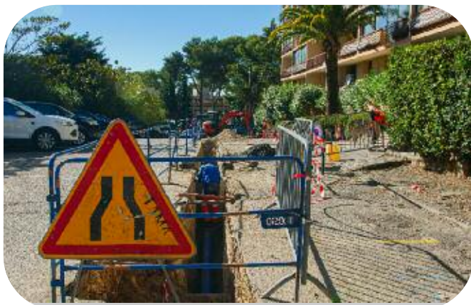
Renouvellement de 1000 mètres de réseau AEP diamètre 100 et 150 mm Résidence Val des Fées, avenue F. Roosevelt, Le Cannet
