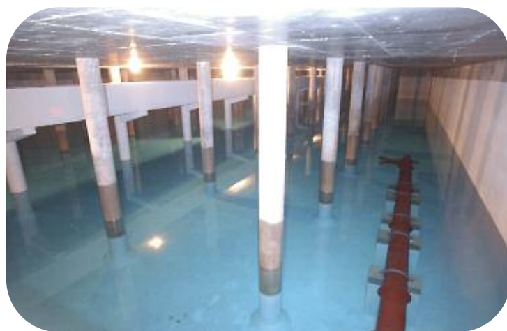
Réservoir du Périer
