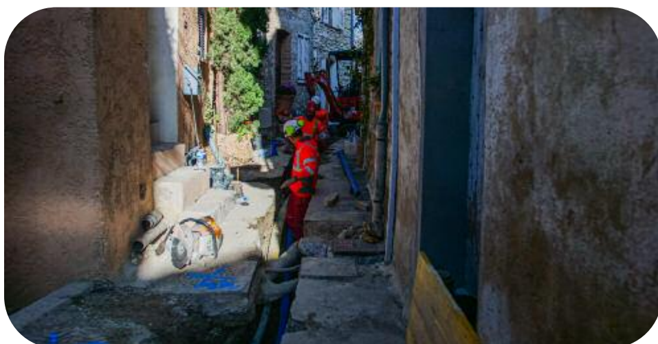
Renouvellement de 250 mètres de réseau AEP, rue des Lombards à Mougins, novembre 2021
