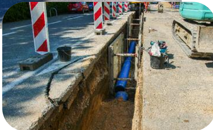
Renouvellement de 800 mètres de réseau AEP fonte DN 300 diamètre 300 mm, avenue Gaston de Fontmichel à Mandelieu, avril 2021
