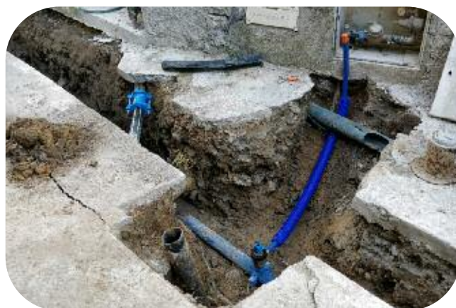
Renouvellement de 120 mètres de réseau AEP, 468 chemin Chemin de la Gabelle à Vallauris, février 2021
