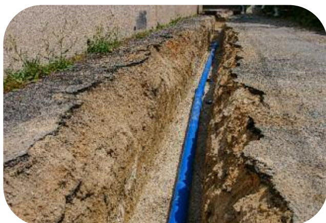
Renouvellement de 340 mètres de réseau AEP, Chemin des chênes à Pégomas, juin 2021
