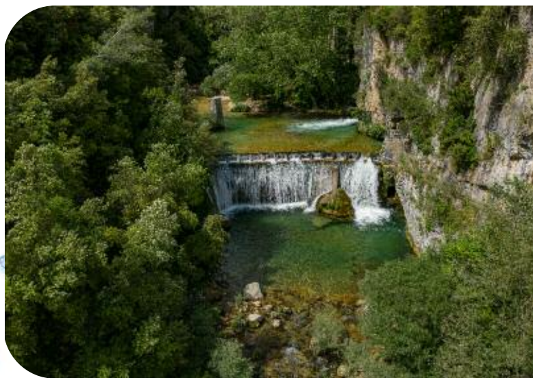
Barrage de Saint-Cézaire-sur-Siagne
