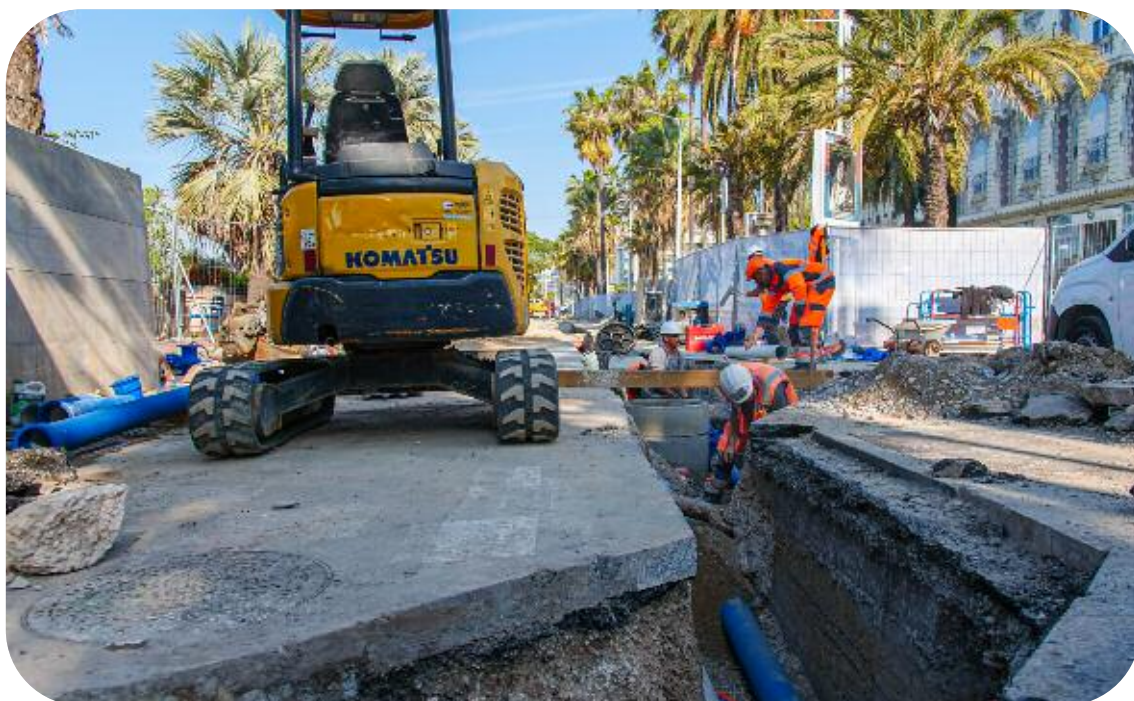
Travaux de renouvellement du réseau d'eau potable Bd de la Croisette à Cannes sur 1100 mètres
