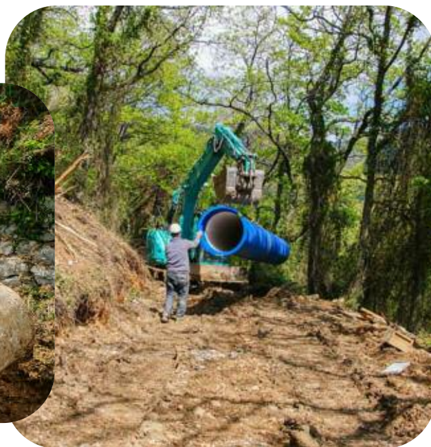
Renouvellement de 110 mètres du Canal du Loup diamètre 800mm phase 2, chemin du Château d'eau à Le Bar-sur-Loup
