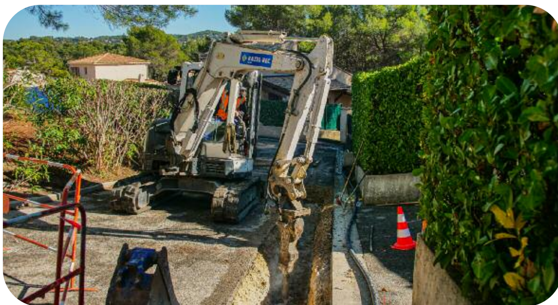
Renouvellement de réseau AEP 250 mètres. Résidence Mas de Pins Mougins, 572 bd de la corniche à Mougins village
