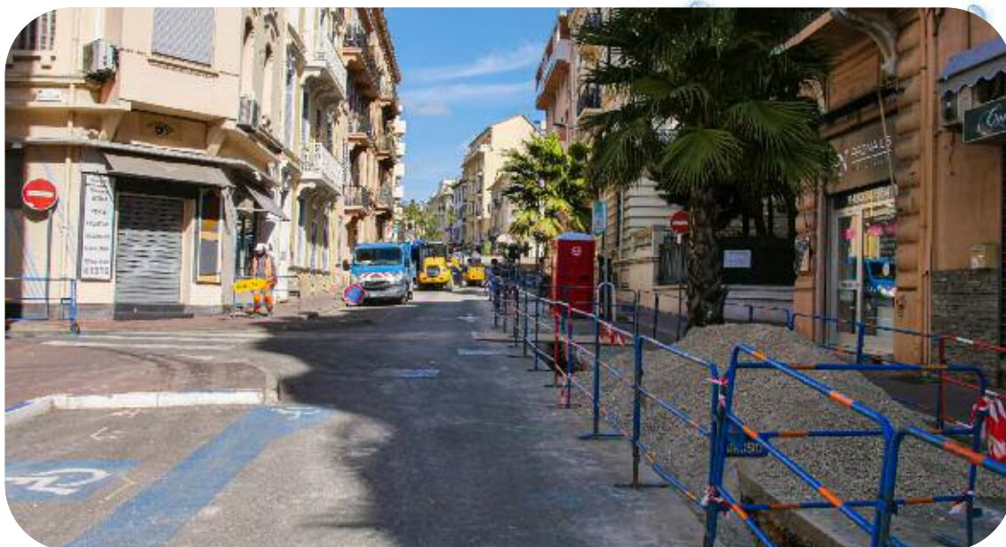
Renouvellement AEP sur 300 mètres, rue Léopold Bucquet à Cannes.
