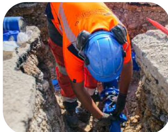
Renouvellement de 1000 mètres de réseau AEP diamètre 100 et 150 mm Résidence Val des Fées, avenue F. Roosevelt, Le Cannet
