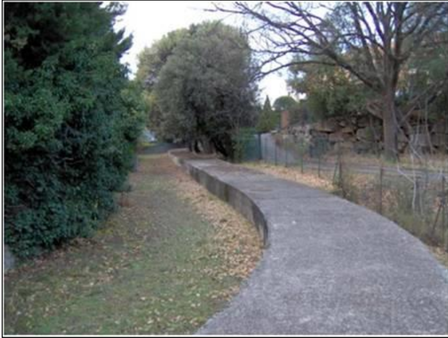
Canal de la Siagne couvert par un dalot
