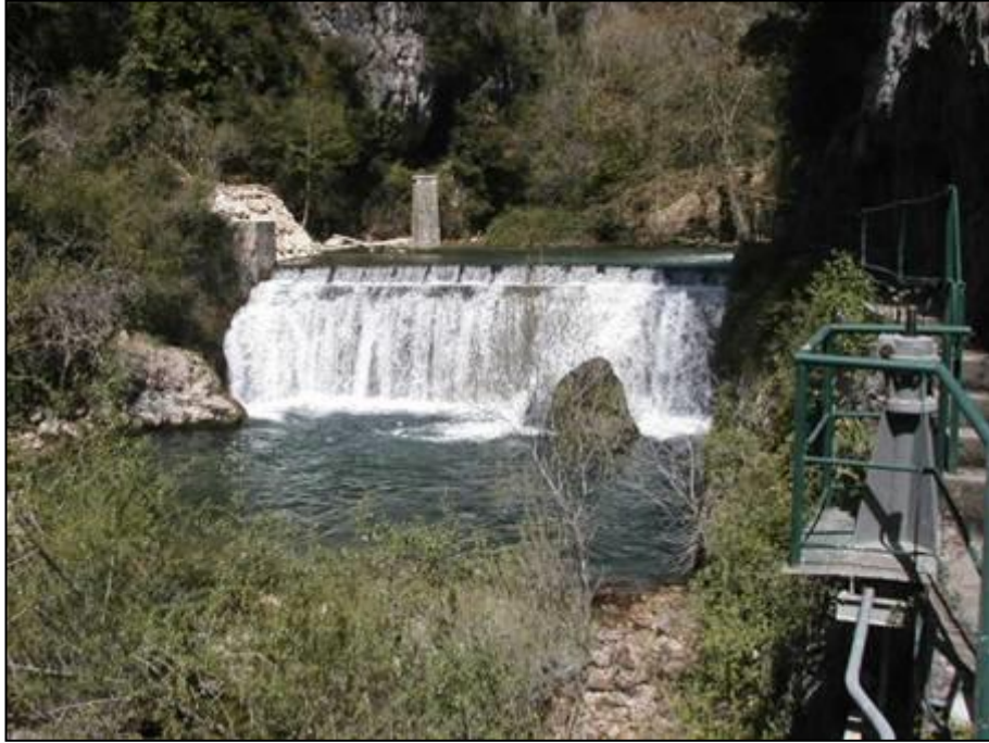
Le barrage du captage en rivière de Saint-Cézaire
