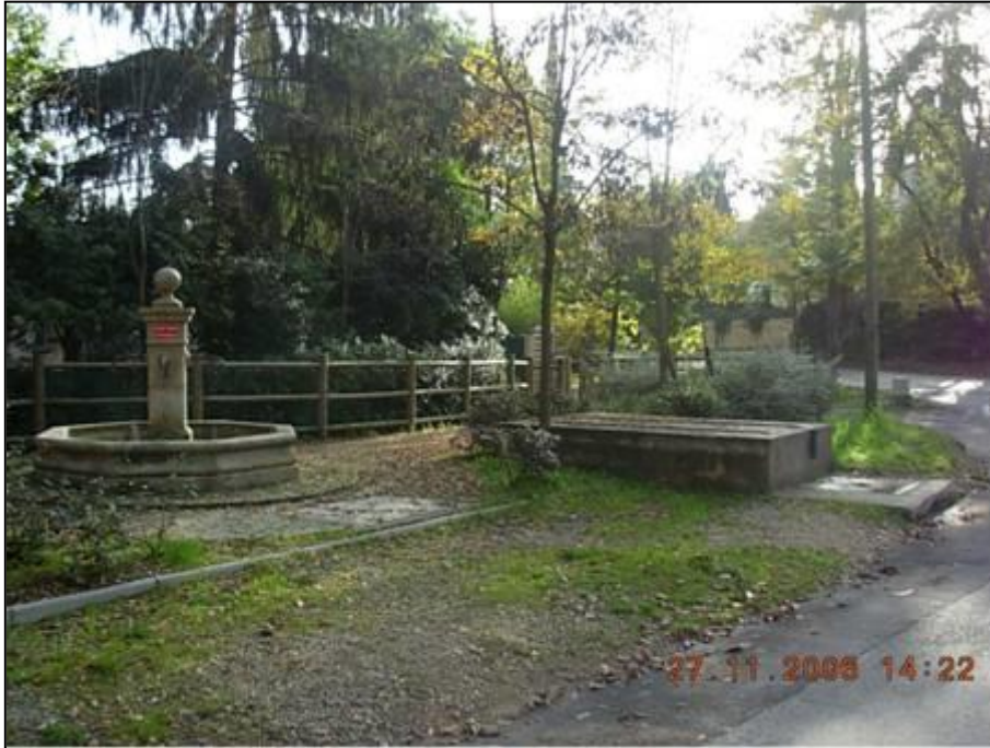
Vanne de départ vers l'usine des Jacourets
