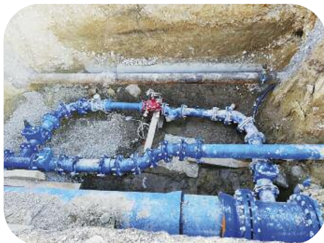
Renouvellement de réseau AEP sur 690 ml en DN500 mm et 690 ml en DN150 mm chemin de l'école vieille à La roquette sur Siagne
