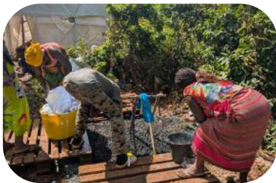
Rampe à eau sur le site de Tsoundzou, 11 juillet 2025.
