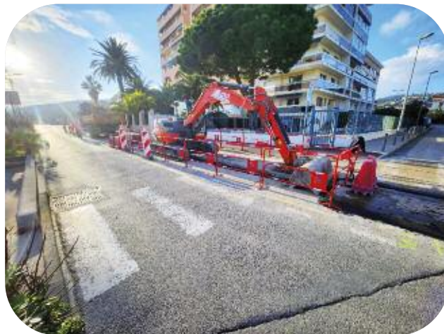
Renouvellement de réseau AEP sur 347 ml DN100 mm avenue des frères Roustan à Vallauris
