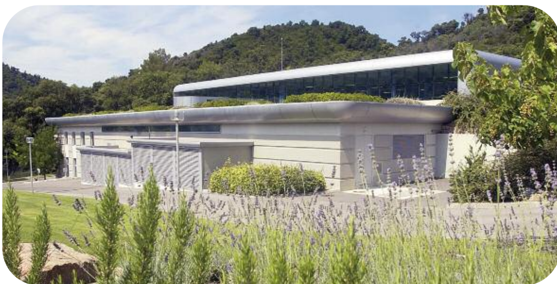
Apié - Usine d'ultrafiltration
