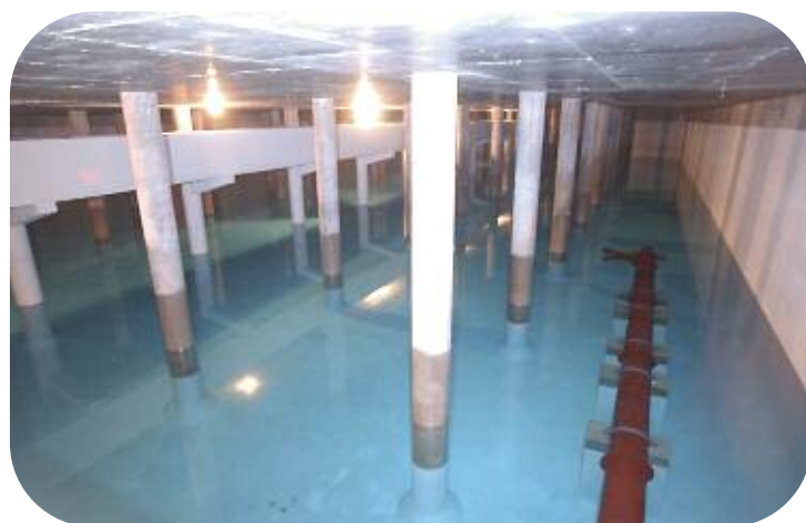
Réservoir du Pérrier
