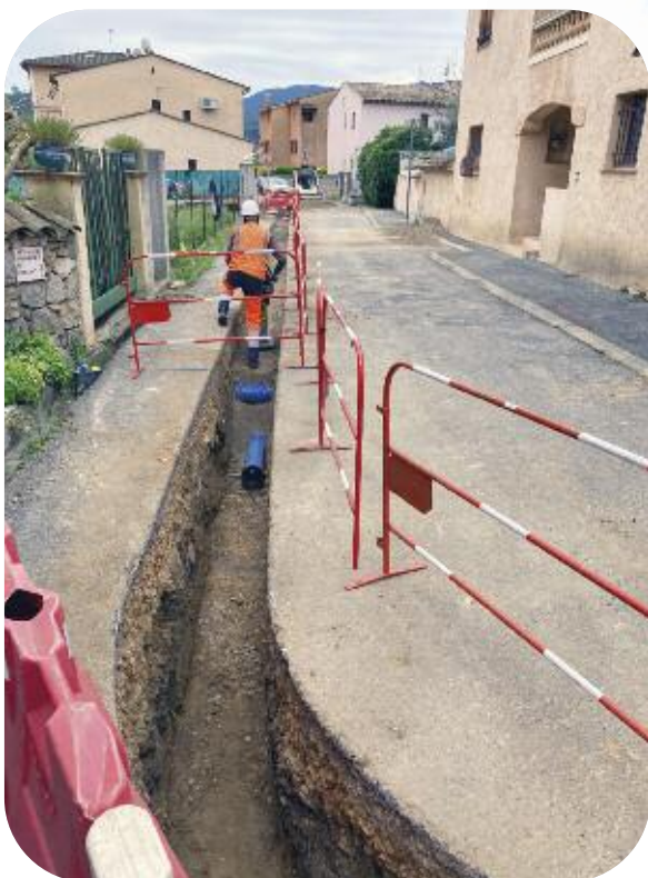
Renouvellement de réseau AEP sur 447 ml en DN 150, 100 et 60 mm chemin de CAREL à Auribeau sur Siagne
