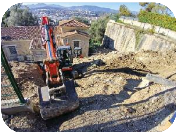
Renouvellement du refoulement Hélios-Marine sur 460 ml en DN 300 mm, 160 ml de DN100 mm et 125 ml de DN60 mm chemin des Chichourliers et chemin des Collines au Cannet
