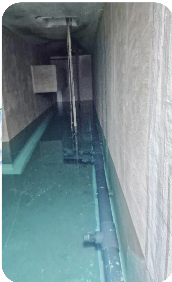
Reprise de l'étanchéité de la Bâche 200 m 3 de l'usine de L'Apié à Peymeinade
