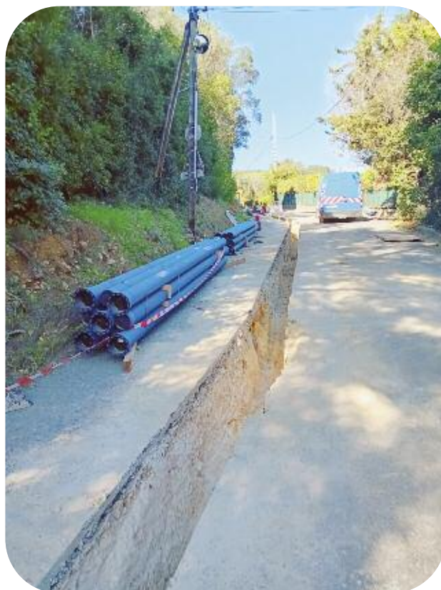
Renouvellement de réseau AEP sur 418 ml en DN150 mm avenue Pibonson à Mougins
