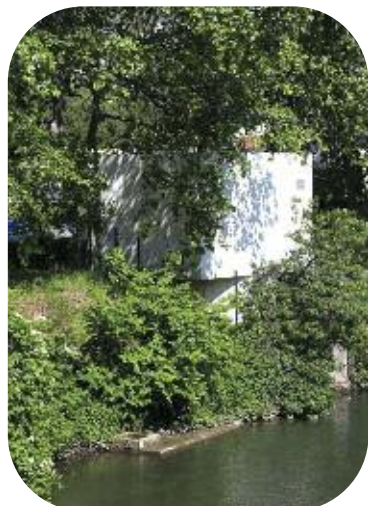
Prise d'eau de la Siagne
