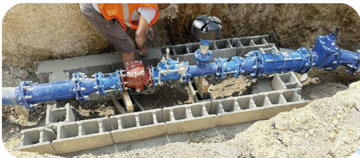
Extension de réseau AEP sur 230 ml en DN150 mm chemin de l'Écluse à Pégomas
