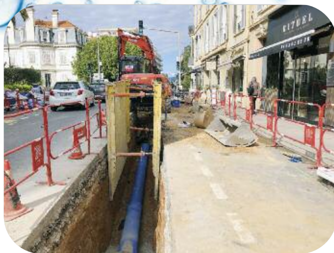
Dévoisement et renouvellement de réseau AEP sur 289 ml en DN400 mm, 596 ml en DN250 mm, 309 ml en DN150 mm, 179 ml en DN100 mm avenue Maréchal Juin à Cannes
