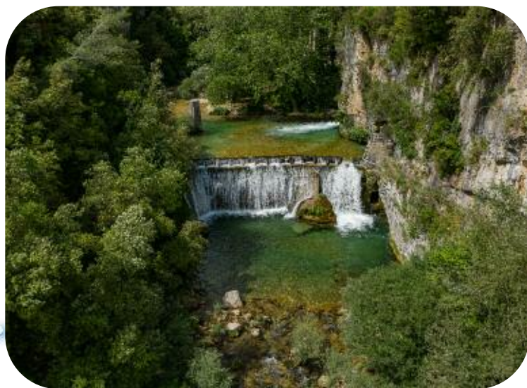
Barrage de Saint-Cézaire-sur-Siagne
