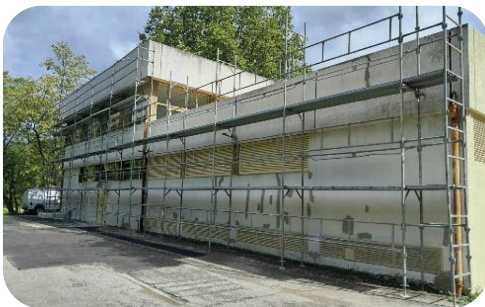
Reprise de la façade de l'usine d'Auribeau, chemin de l'Écluse à Pégomas
