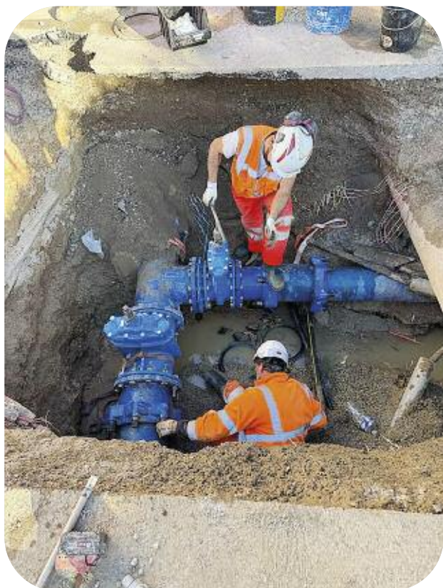
Renouvellement de réseau AEP sur 115 ml en DN300 mm rue Anatole France à Mandelieu la Napoule
