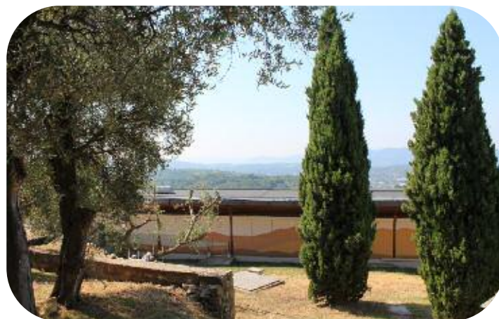
Usine de Châteauneuf
