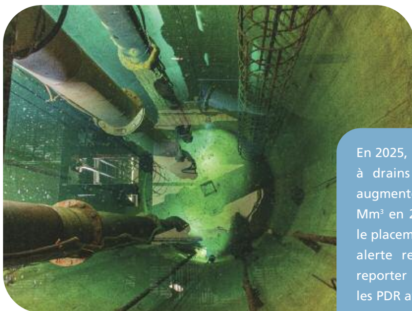
Puits à drains rayonnants
