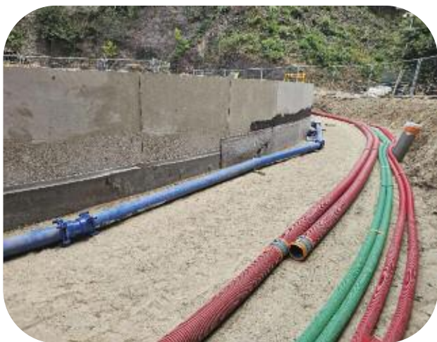
Extension de réseau AEP, renforcement DECI sur 319 ml en DN150 mm parking Pastor à Théoule
