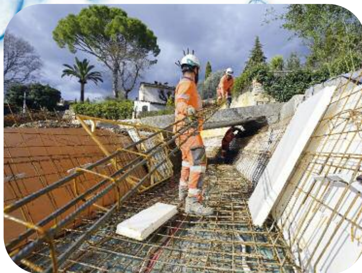
Travaux de reconstruction du canal de la Siagne. Chômage de janvier 2025 sur 120 ml, 188 route de Plascassier à Grasse
