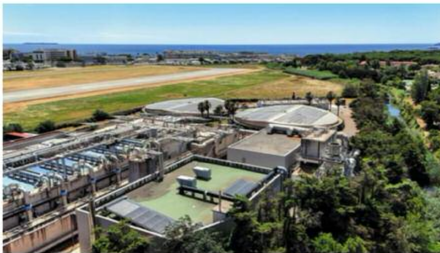
La station Aquaviva, située à Mandelieu-la-Napoule, pourrait entrer dans une nouvelle dimension : l'objectif de la CACPL va être de réutiliser près de 15 millions de m 3 d'eau par an. PHOTO AGGLOMÉRATION CANNES PAYS DE LÉRINS
