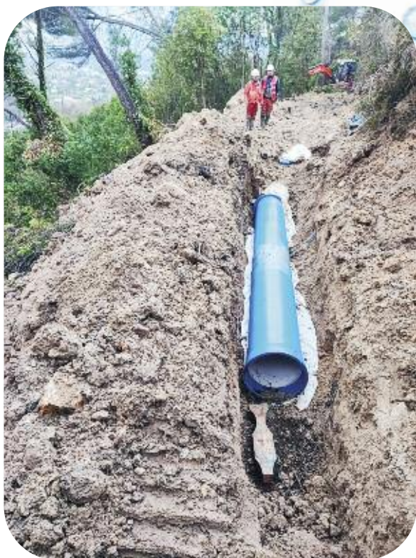
Travaux de renouvellement du Canal du Loup. Chômage de Mars – Avril 2025 sur 400 ml, Chemin de Pigranel à MOUGINS
